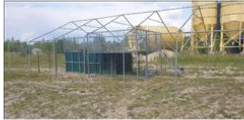
Бассейн в процессе сборки Каркас шатра над бассейном, последняя стадия сборки
